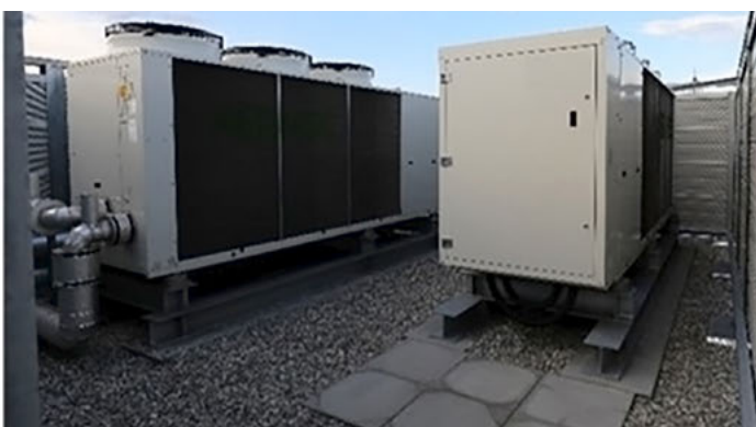
Fig.1 : système PAC en monovalence : bâtiment (gauche) ; PAC air/eau en toiture, avec panneaux insonorisants (droite)
